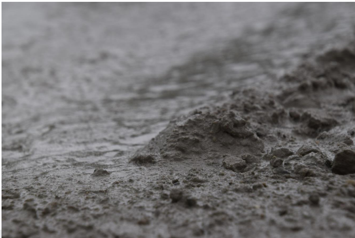
Foto: Detail betonmortel.
