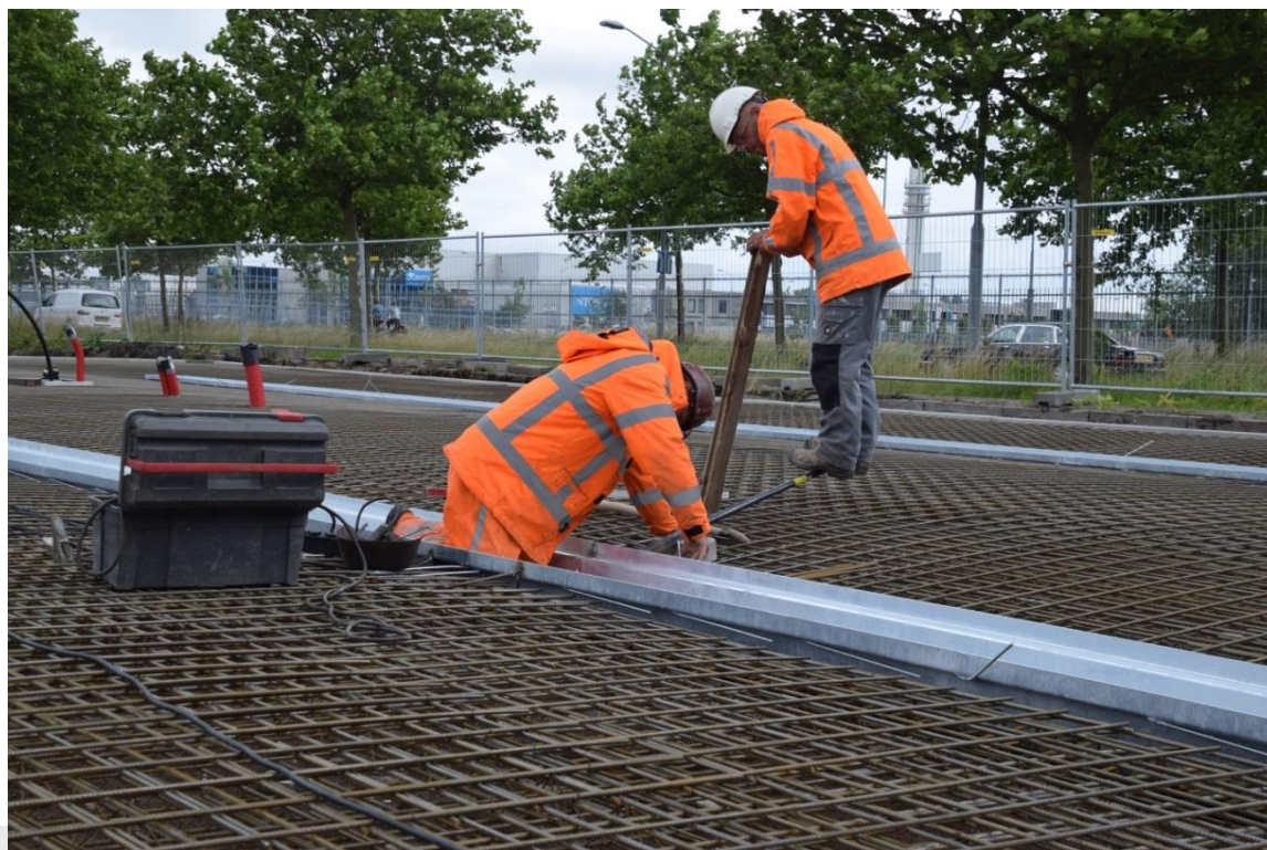
Foto: Aanleg wapening voorziening.
